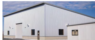
工学試験棟／大型実験施設 (491m×高さ6.1m)
